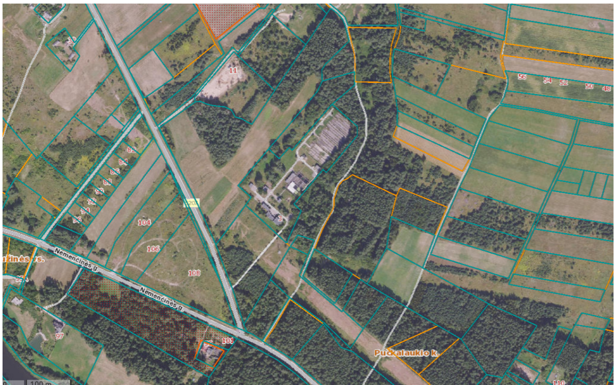
1 pav. Rekonstravimo, statybos ir griovimo objektų sklypo vieta
